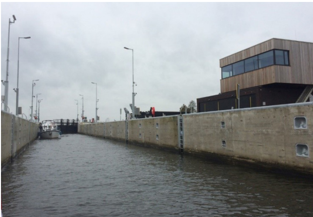
De Reevesluis met gesloten sluisdeuren.
