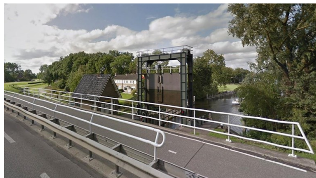
Foto boven: Sluisdeur vanaf de weg gezien Foto links: Sluis en sluisdeur vanaf het Ganzendiep gezien.
