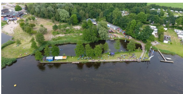
Het terrein van Skonenvaarder in vogelvlucht. De Roggebotsluis ligt aan de westzijde. De Nieuwe Reevesluis ligt aan de oostzijde
