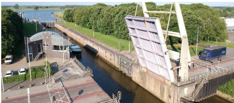
De Spooldersluis en de Spoolderbrug.
