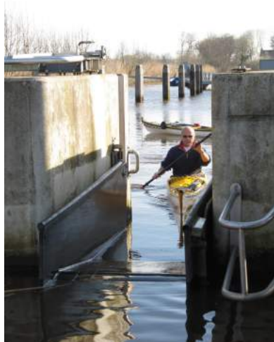
De kanostuw naast de sluis bij Schaphalsterzijl
