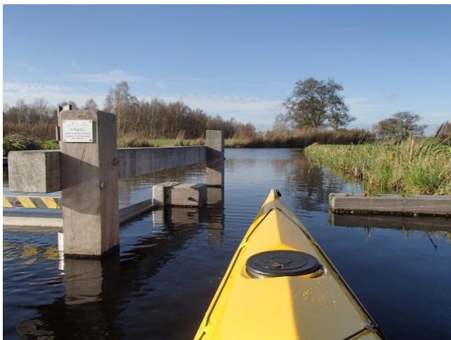
De kanodoorgang naast de klepstuw
