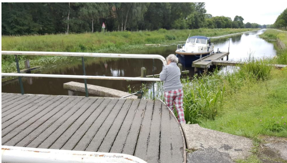
Foto: Ruiten Aakanaal Oude storingsgevoelige bruggen die, lopende over een smalle richel, met de hand moeten worden opgedraaid zijn volstrekt niet veilig voor de vaarrecreant.
